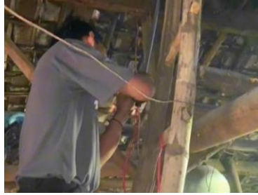
Gambar 2. Pemasangan Paralon Sebagai Pelindung Kabel
